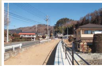
■国道141号 交差点改良・拡幅・歩道設置 (高根町 長沢交差点)
