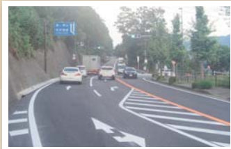
■国道141号 右折レーン設置 (須玉町若神子 小手指交差点)
