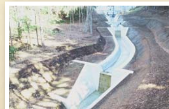
■和入沢砂防堰堤 (須玉町下津金地内)
