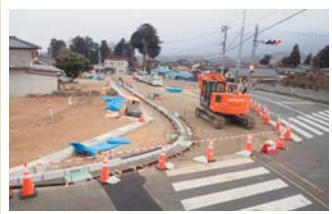
■葎崎増富線 交差点改良・拡幅・歩道設置 (明野町小笠原)
