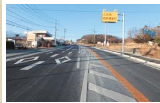
■国道141号 交差点改良・右折レーン設置 (高根町清里 念場原地区)
