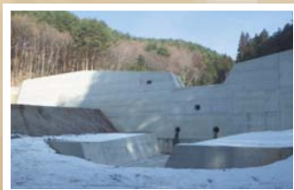
■下原沢砂防堰堤 (須玉町下津金地先)
