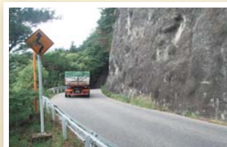
■葎崎増富線 仮称:江草大渡トンネル (須玉町江草大渡)
