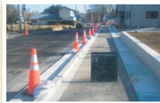
■茅野北杜葎崎線 拡幅・歩道設置 (長坂町日野春 駅前)
