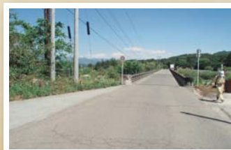
■横手日野春停車場線 駒城橋架替 (武川町柳沢～白州町横手)
