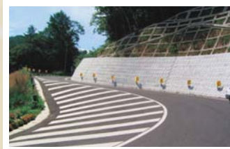
■清里須玉線 待避所整備 (海岸寺付近)
