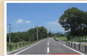
■広域営農団地農道整備事業 ハヶ岳南 農業・地域振興地区
